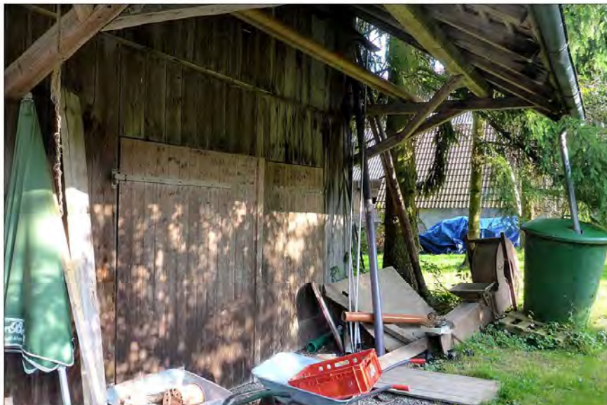
Abbildung 5: Westseite des abzureißenden Schuppens. Der Schuppen bietet viele Möglichkeiten für gebäudebewohnende Fledermausarten.
