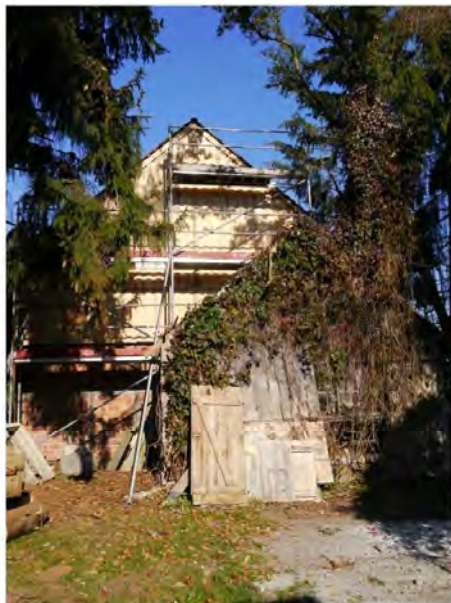
Abbildung 2: Holzschuppen sanierte Außenseite
