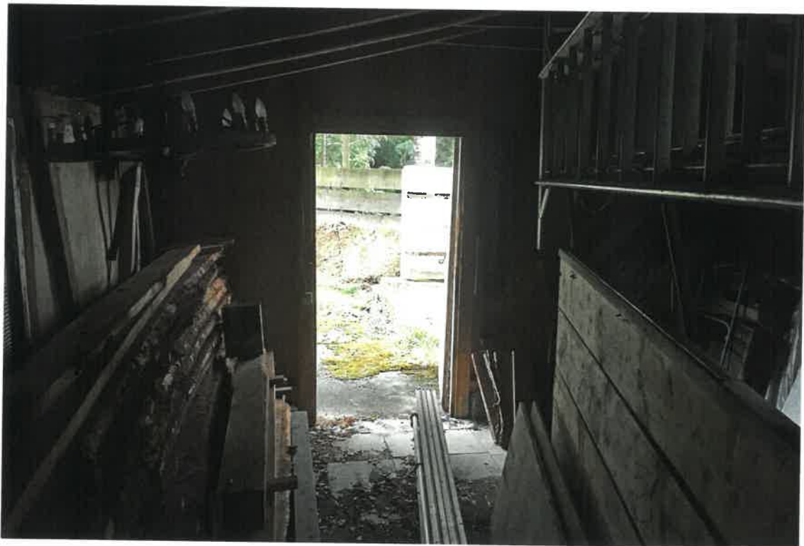
Abbildung 5: Der Innenraum des Schuppens. 31.8.18.
